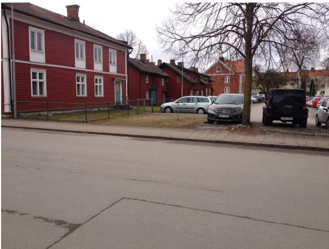
Bild2. Träbyggnader, fasader mot norr
