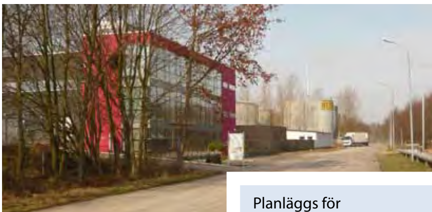
Ny befintlig bebyggelse i verksamhetskvarteren
