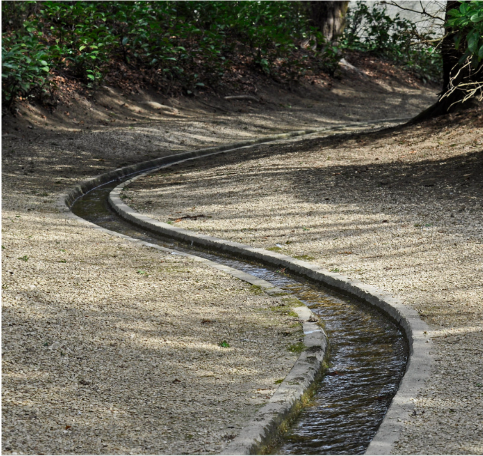
Figur 11: del av rinnvåg som utgörs av en öppen ränna nära marknivå
