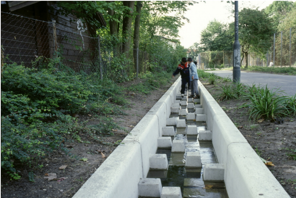
Figur 12: rinnvåg i form av en så kallad "kubbäck" för större dagvattenflöden (bild: St. Eriks)
