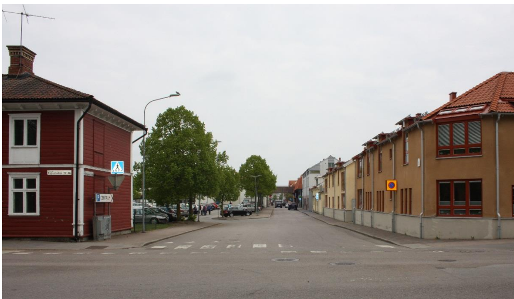
Figur 14 Dagens utformning av Norra Torngatan. Dubbelriktad med cirka 15 meter mellan fasaderna.
