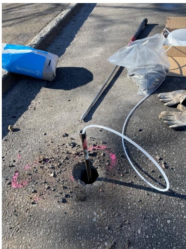
Figur 6. Installation av porgasspetsar. © Ensuccon AB
