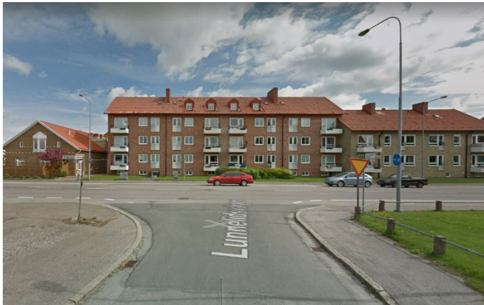
Figur 7. Kulturhistoriskt värdefull byggnad på Skopan 17.
