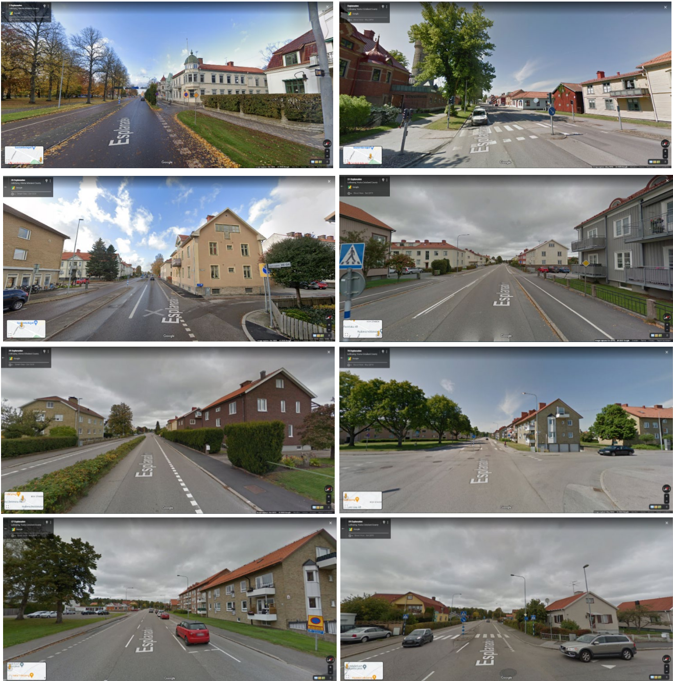
Figur 12. Åtta vyer längs Esplanaden sett åt väster, med start vid Wennerbergsbron och slut vid aktuellt planområde, Skyffeln 2. Bebyggelsen längs Esplanaden har varierande fasader där det röda taket är ett genomgående inslag.
