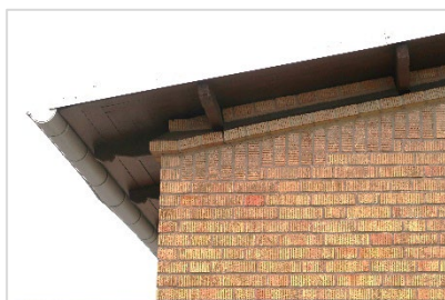
Figur 10: k 5 - Takfotsutformning med formsågade tassar ska bevaras
