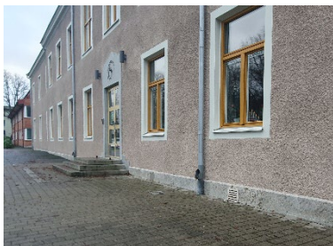
Figur 12: k 7 - Byggnadens putsade ytor ska bibehållas
