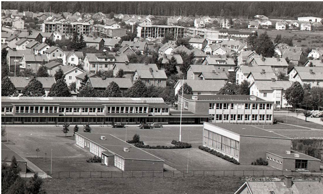
Figur 18: Översiktsbild mot nordväst med Rudenschöldskolan i förgrunden. Fotot är taget från Vattentornet (1960-tal).
