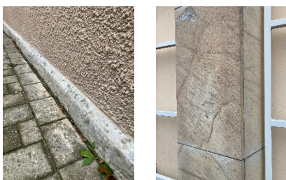
Figur 8: k 3 - Naturstensdetaljer i fasad ska bibehållas
