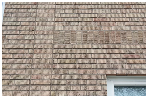
Figur 7: k 2 - Fasadens tegelmurar ska bibehållas i sin utformning (mönsternurning)
