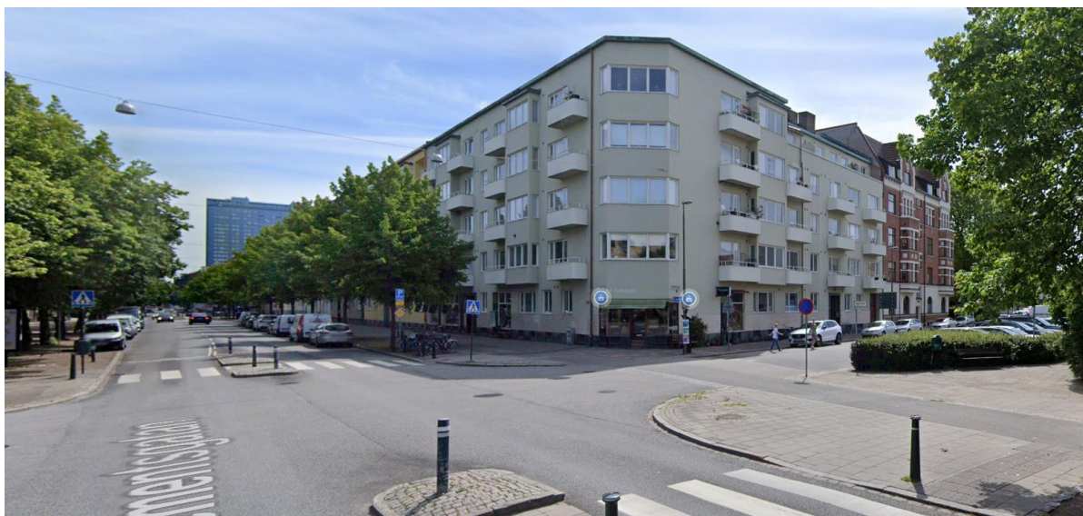
Figur 27. Regementsgatan i Malmö. Till höger om körbanan löper en cykelbana som har utformats genomgående så att bilister i Beridaregatan (till höger i bild) har väjningsplikt mot cyklister. Avståndet mellan cykelbana och körbana möjliggör väntande personbil utan konflikt med cykelbana.
