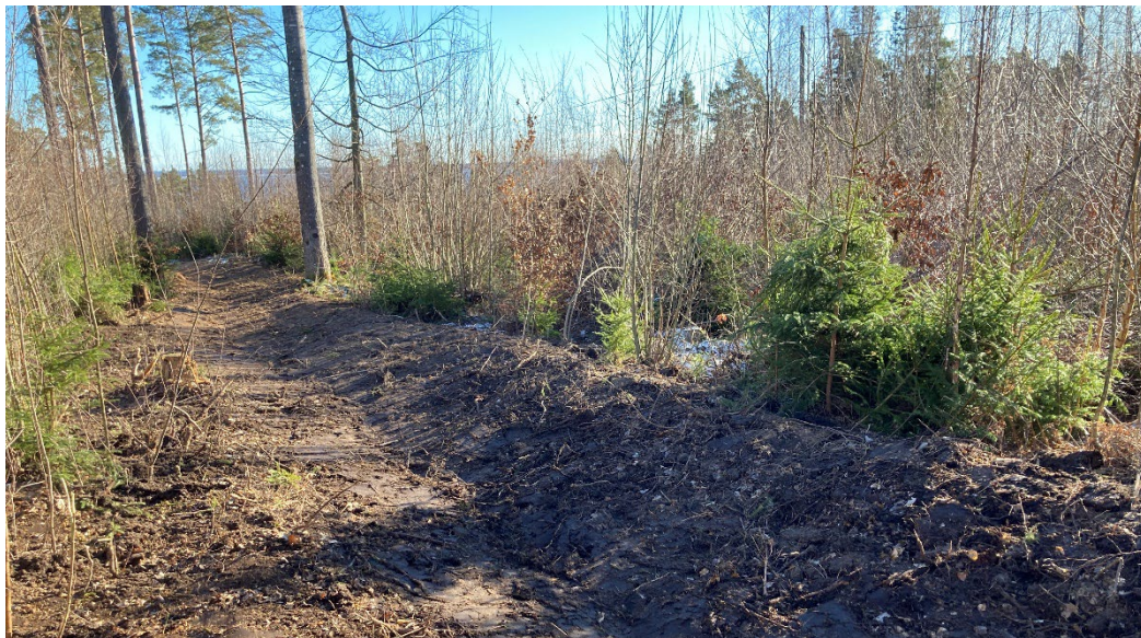
Figur 43 Nyanlagd rinnväg för skyfallsvatten, 2025-02-17
