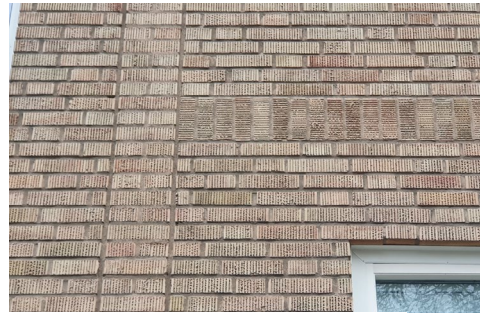
Figur 7: k 2 - Fasadens tegelmurar ska bibehållas i sin utformning (mönstermurning)
