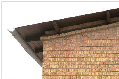
Figur 10: k 5 - Takfotsutformning med formsågade tassar ska bevaras
