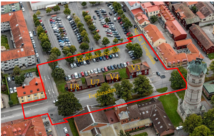
Planområdets läge i stadens centrum. Planområdet är rödmarkerat. V3= Vulcanus 3, V4= Vulcanus 4, U7= Uranus 7 och U8= Uranus 8.
