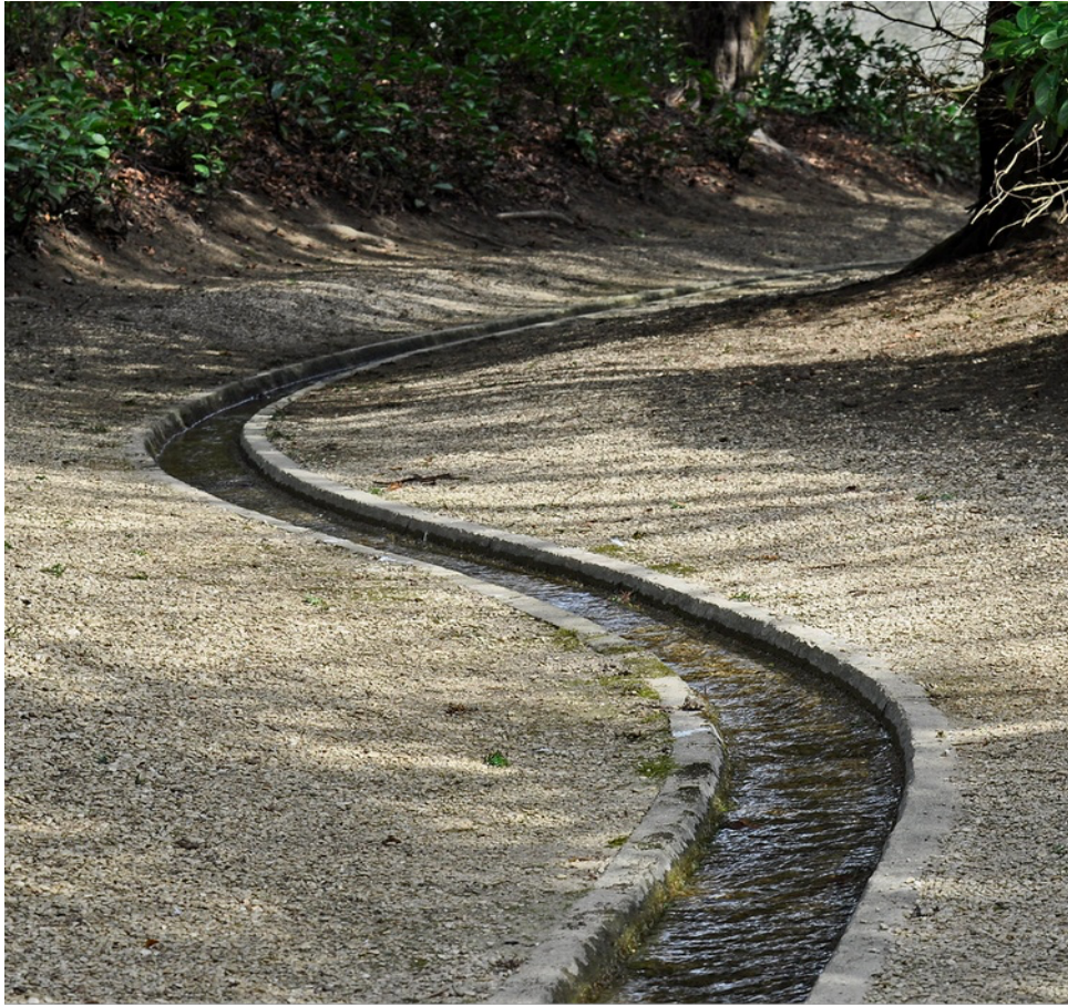
Figur 11: del av rinnväg som utgörs av en öppen ränna nära marknivå
