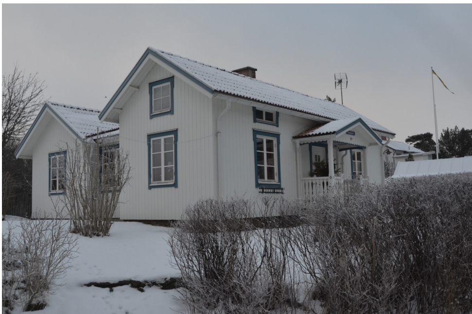
Ekebo 1:19, Nordvik. Byggt ca 1900. Efter 1981 har huset byggts till kraftigt men känsligt.
