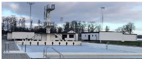
Framnäsbadet, foto Ateljé Arkitekten
