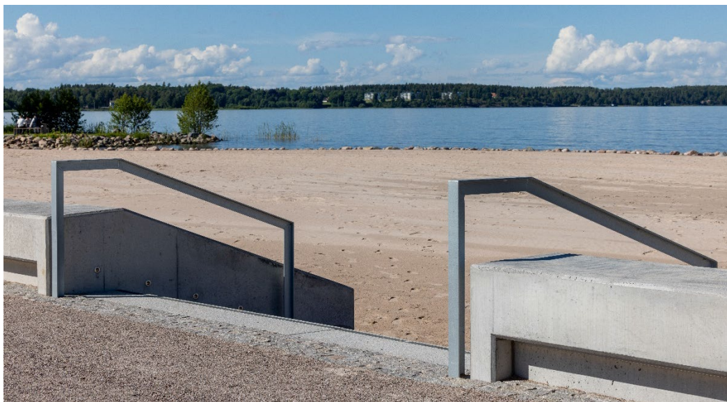
Figur 44 Stranden med yttre stenskonning samt platsgjutna betongmurar utmed strandpromenaden.
