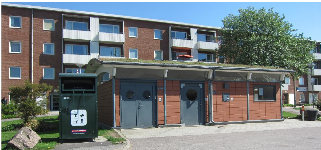
Avfallsutrymmens placering behöver noga övervägas för att skapa en trygg och ändamålsenlig avfallshantering. FOTO: DAVID ALTHOFF PALM, RAMBOLL.
