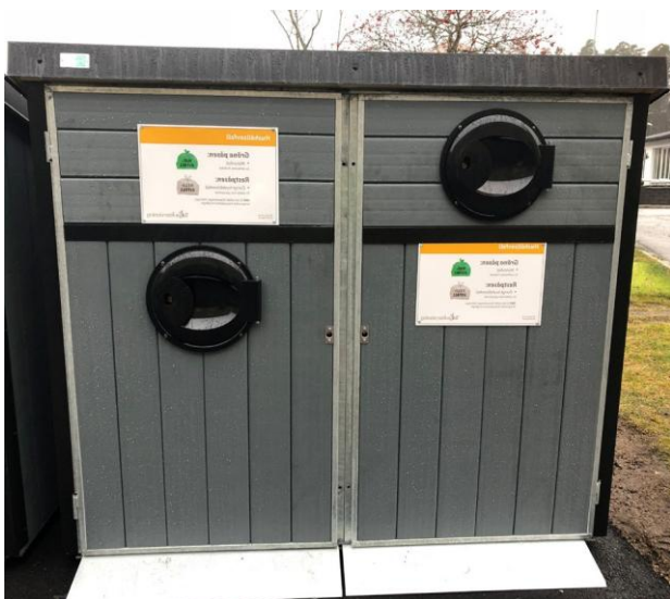
Kärslåp med nedsänkt inkasthål för att öka tillgängligheten. FOTO: TELGE AB.
