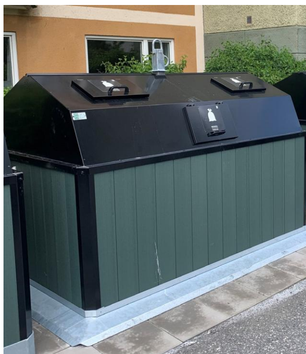
Bottentömmande behållare där avfall lagras delvis under jord. FOTO: HANNA GUSTAVSSON, RAMBOLL.
