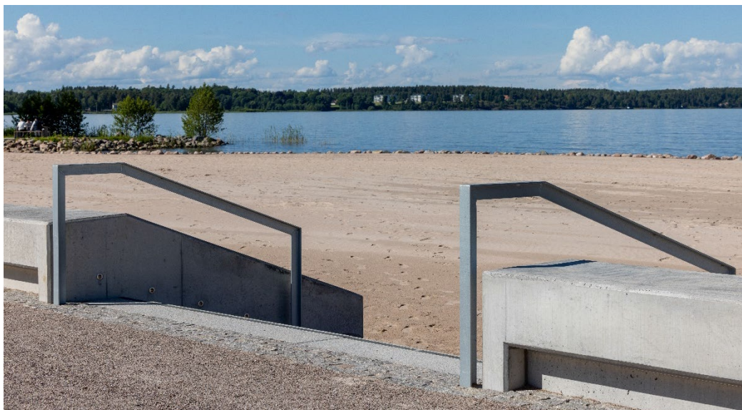
Figur 49 Stranden med yttre stenskoning samt platsgjutna betongmurar utmed strandpromenaden.
